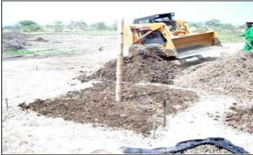
Figura 4. Armado de base de pila piramidal en la planta norte de compostaje.
